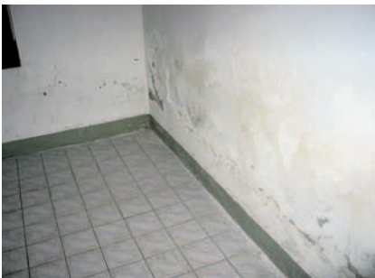
Abb. III.1.22: Verschieden hohe Feuchtigkeitshorizonte bei zeitweise drückendem Grundwasser
